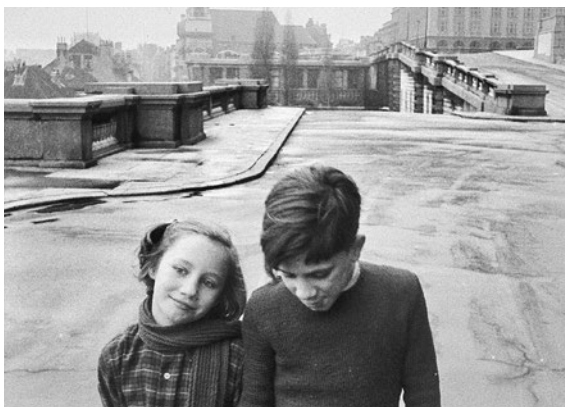
Le Chantier des gosses
